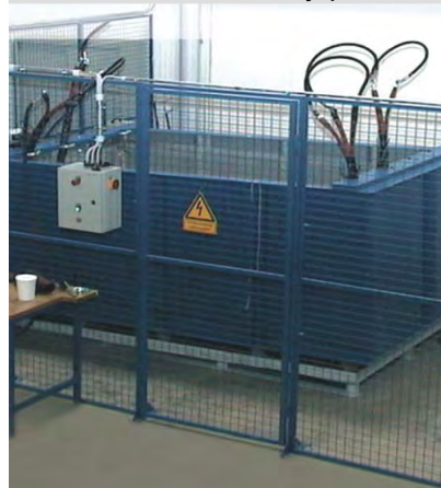
Контейнер с водой для производства нагревательных циклов кабельных муфт
